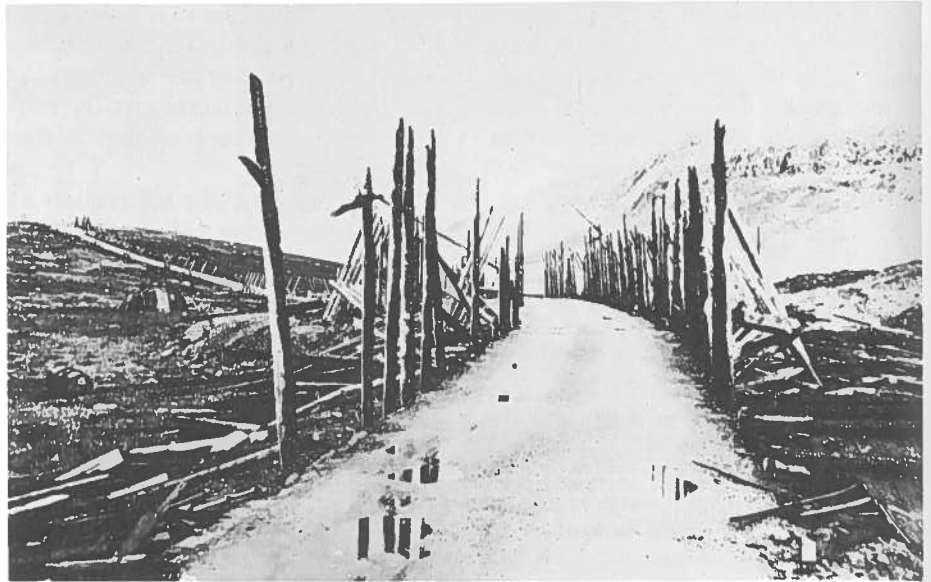
Tyskernes forsøk på å bygge vintervei over Kvæangsfjellet endte slik. Brannhøsten 1944 gikk den 4 km lange tretunnelen opp i flammer. Slik så det ut i mai 1945.
